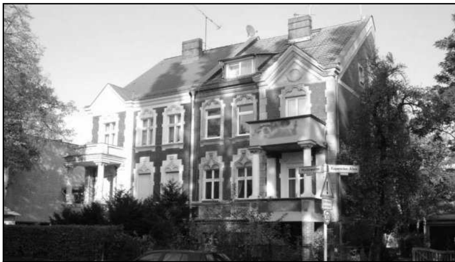
Doppelmietshaus Waldowallee 15/17 - erbaut 1902
